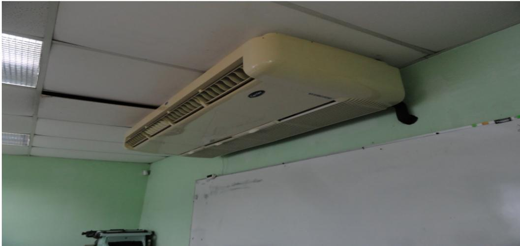
Foto 5: aire acondicionado laboratorio CU Siquirres, no se encontró en buen estado pero funcionaba. Tienen la Debilidad que son aires de confort y no de precisión por lo que pueden expulsar agua o fragmentos de hielo y dañar equipo electrónico ubicado cerca del mismo. Fecha: 14/11/13
